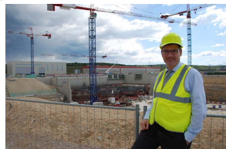
Auf der Baustelle für das Reaktorgebäude.
